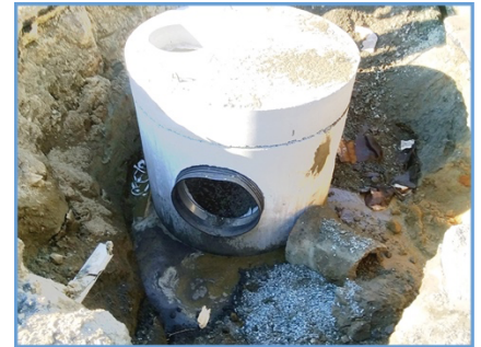
Exemplo de bueiro de drenagem que será instalado.
