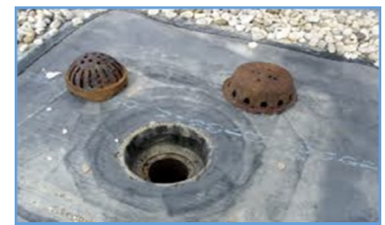
Drenagem do telhado
