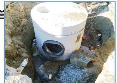
将要安装的雨水排水检修井示例
