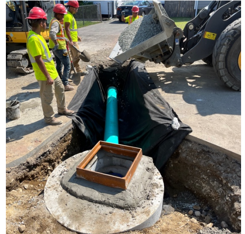
Instalação de bueiro de drenagem
