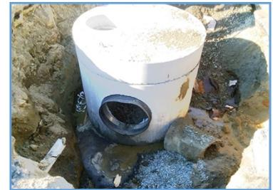
Ejemplo de pozo de inspección de drenaje a instalar
