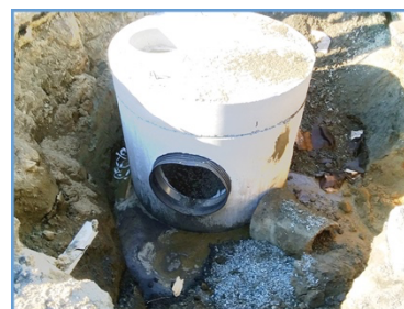
Exemplo de bueiro de drenagem que será instalado.
