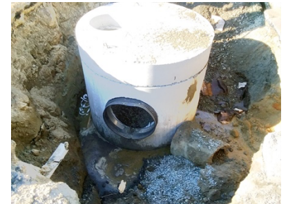
将要安装的排水检修孔示例
