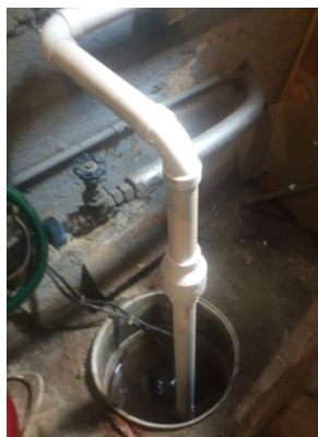
污水泵（上图） 屋顶引水管（右上） 屋顶排水管（右）
